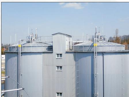
Intenzifikace čistírny odpadních vod Cheb s navrhovanou kapacitou 65 000 EO byla realizována v letech 2011- 2013. Čistírna odpadních vod zabezpečuje vycistění splaškových a ostatních odpadních vod z měst Cheb a Františkových Lázní mechanicko-biologickým způsobem. Cílem stavby bylo snížení znečištění řeky Ohře organickými látkami a nutrienty.
